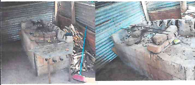
Foto 5: Estufa rural deteriorada.
